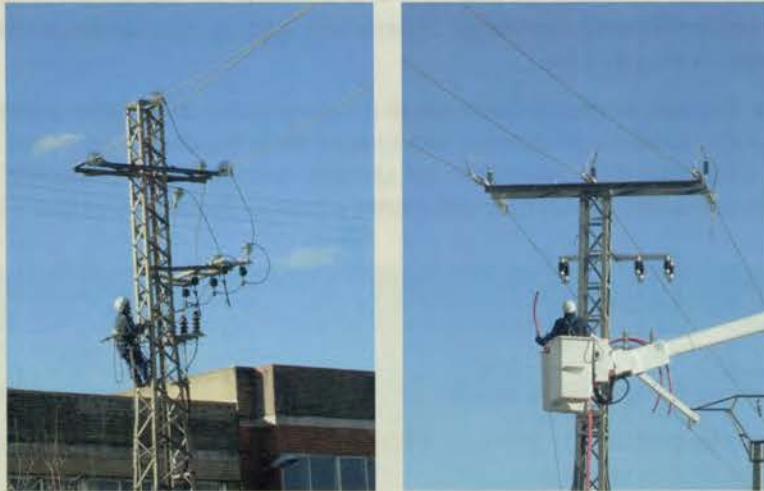
Figura 3.34. Diferentes procedimientos de subida a los apoyos para realizar operaciones de montaje y mantenimiento. A la izquierda se ve que el operario trepa con un arnés de seguridad, con mayor riesgo de caídas que en el caso de la derecha, donde el trabajador actúa desde una cesta elevada por una grúa.
