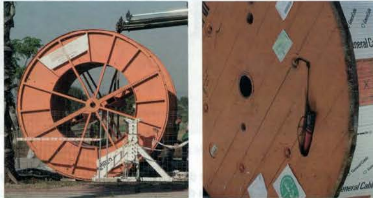
Figura 4.19. Descarga de bobinas de cable y capuchón en la punta.
