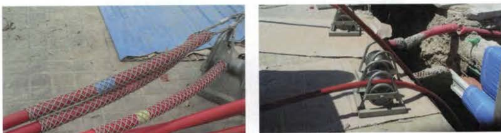
Figura 4.24. Paso del cable con punta conectada al cable guía.
