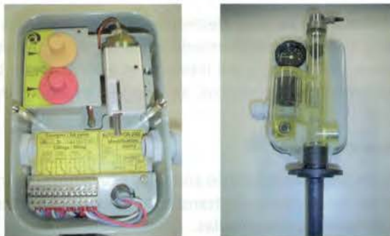
Figura 2.22. Protección de sobrecarga con bloque DGPT-2.
