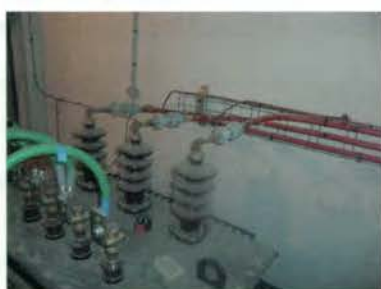
Figura 2.12. Transformador de acometida subterránea (terminales de goma/botellas enchufables).
