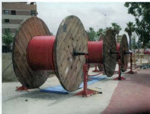
Figura 4.20. Bobinas correctamente apoyadas para tendido.
