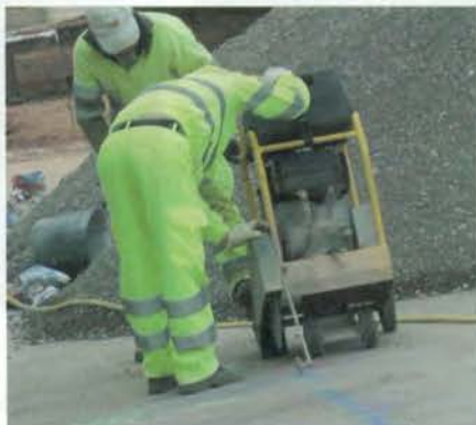
Figura 4.14. Replanteo y corte del trazado de línea subterránea de BT.
