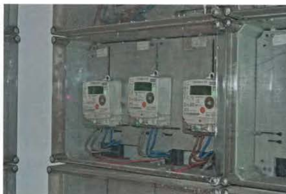
Figura 6.31. Unidad funcional de medida.
