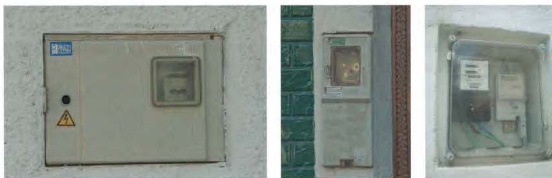
Figura 6.19. Distintos tipos de CPM según su forma de instalación. La de la derecha corresponde a un modelo de interior aunque no lleva puerta; la de la izquierda y la central son modelos de exterior.
