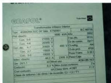
Figura 2.13. Placa de características de un transformador de potencia.
