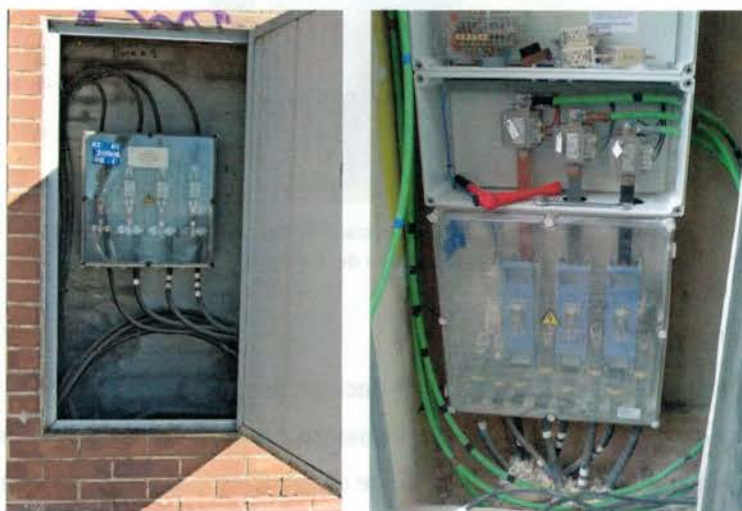
Figura 6.5. Cajas generales de protección.
