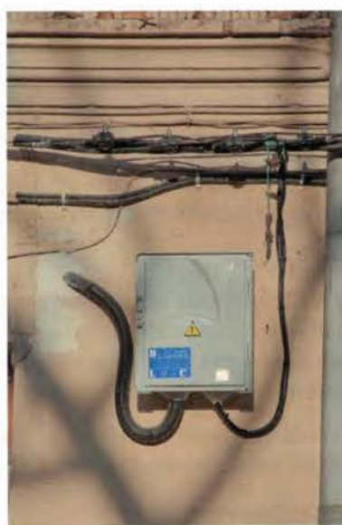
Figura 5.6. Acometidas en derivación. La de la izquierda se corresponde con una acometida subterránea mientras que la de la derecha con una acometida aérea.
