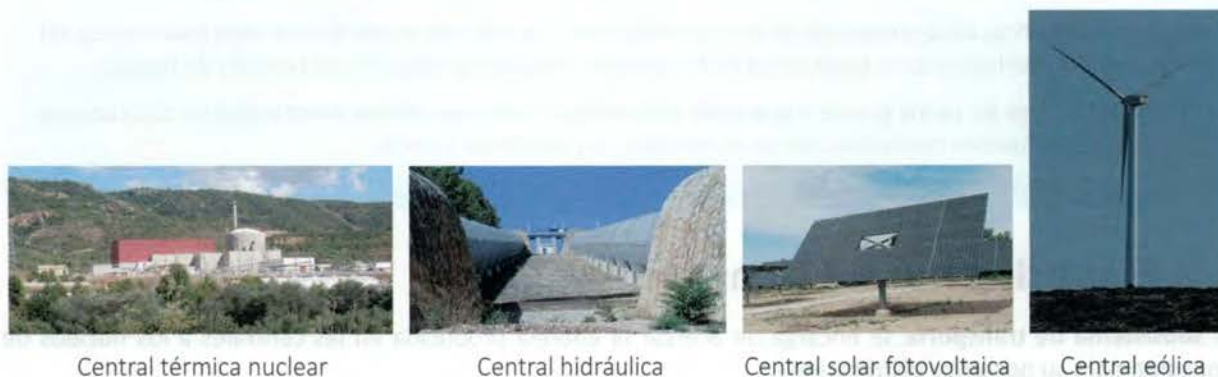
Figura 1.2. Diversas centrales eléctricas.
