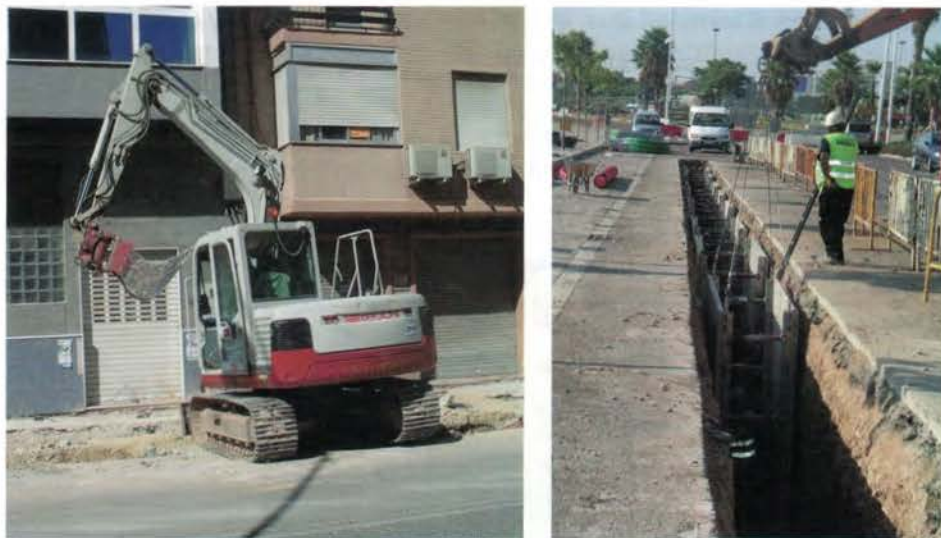
Figura 4.16. Apertura de la zanja y entibado.
