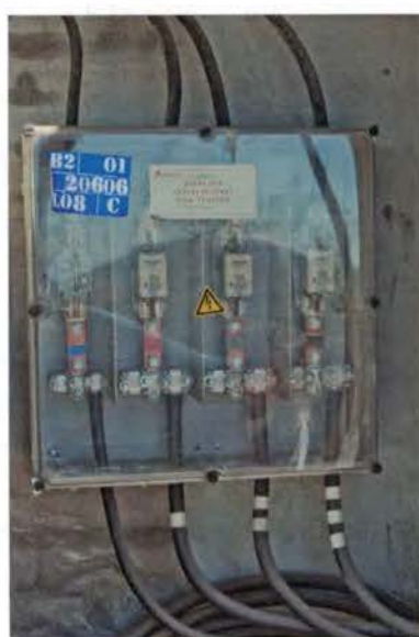
Figura 5.6. Acometidas en derivación. La de la izquierda se corresponde con una acometida subterránea mientras que la de la derecha con una acometida aérea.
