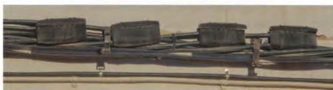
Figura 3.14. Ejecución de una derivación con cubiertas para redes trenzadas.
