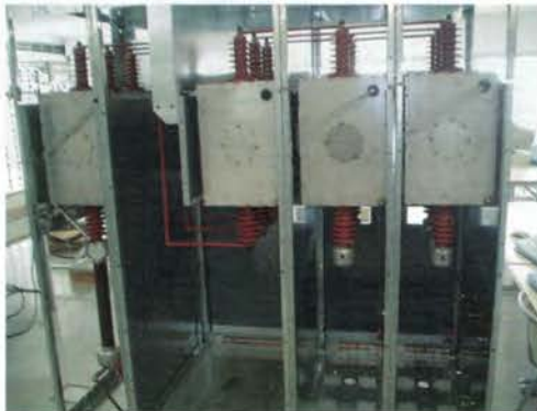
Figura 2.52. Conexión entre celdas de línea, remonte y protección con fusibles APR de un CT de abonado con fines didácticos.
