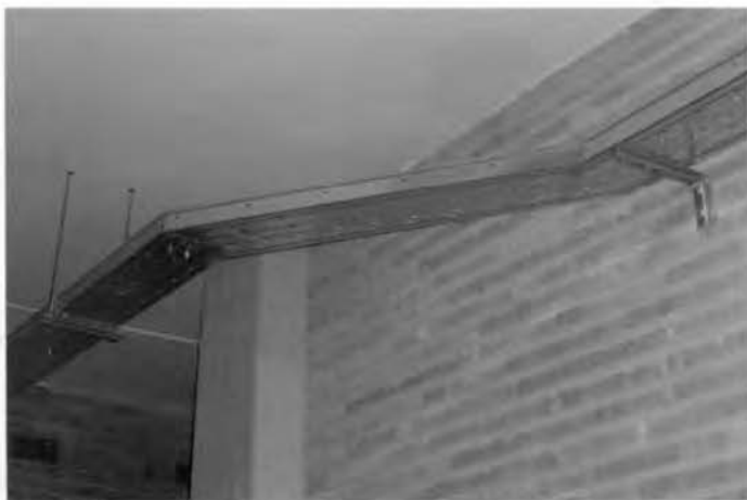
Figura 4.31. Ejemplo de trazado y juntas de una bandeja de acero galvanizado.
