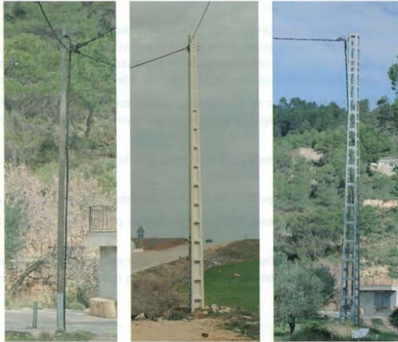
Figura 3.28. Diferentes apoyos para líneas de distribución aérea de BT. De izquierda a derecha: de madera, de hormigón armado y metálico de perfiles laminados.
