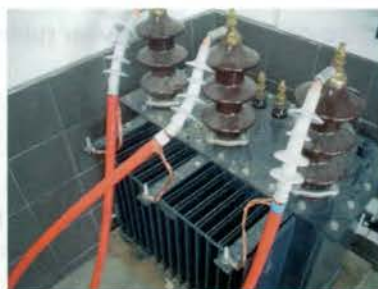
Figura 2.56. Conexión en el lado de AT (transformador).
