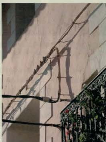
Figura 3.25. Detalle del paso de una red posada a tensada en el cruce de una calle.
