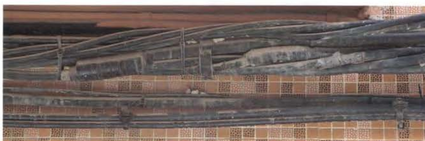
Figura 3.13. Ejecución de una derivación con elemento conductor recubierto con cinta aislante.
