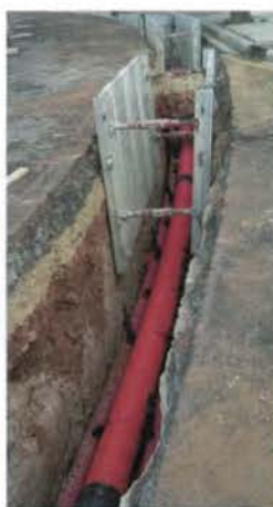
Figura 4.17. Tendido de tubos de forma manual.
