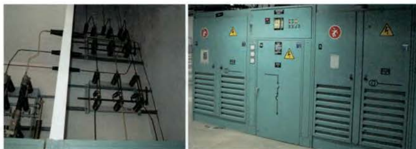
Figura 2.30. Celdas de ejecución in situ y modulares de corte al aire.
