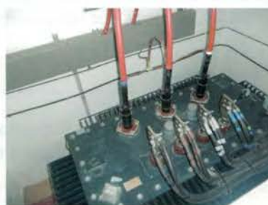
Figura 2.12. Transformador de acometida subterránea (terminales de goma/botellas enchufables).
