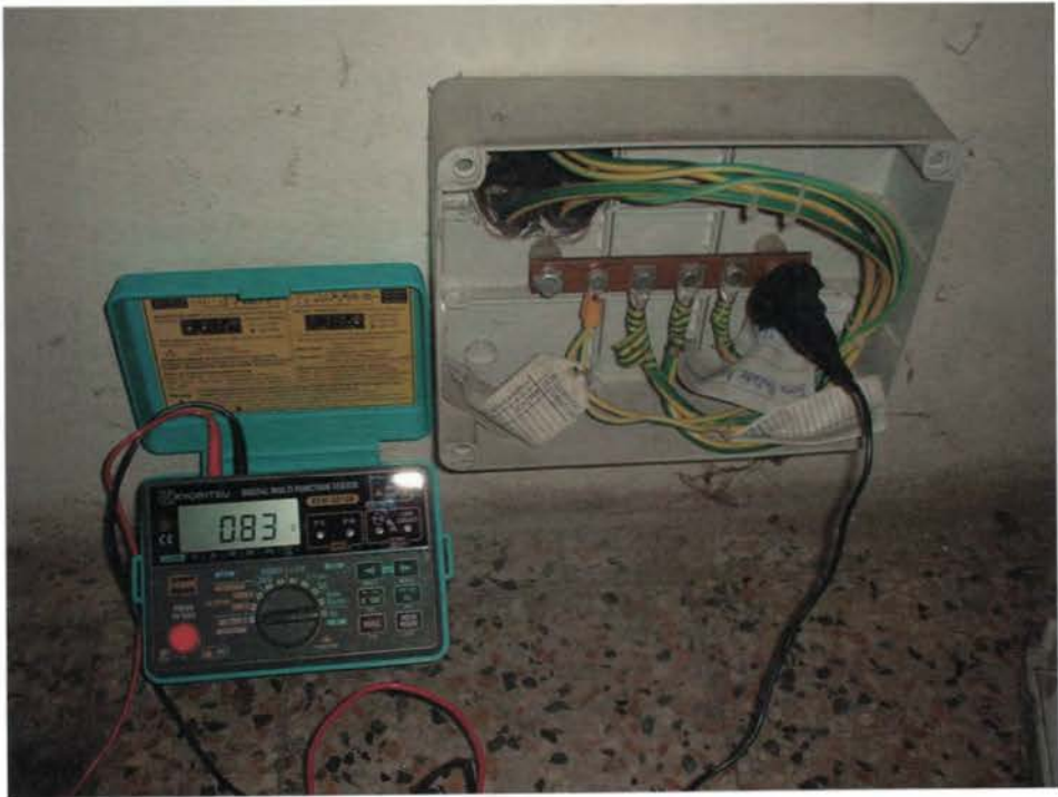
Figura 7.6. Medida de resistencia en conductores de protección.
