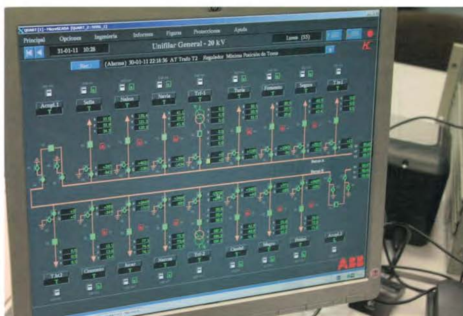
Figura 1.18. Programa de telegestión de la red eléctrica. Un operario desde el centro de control puede conocer en tiempo real y de manera remota los parámetros de funcionamiento de distintos elementos de la red.
