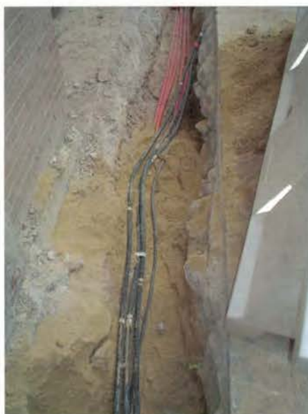
Figura 4.1. Línea de distribución trifásica (3 F+N) directamente enterrada.
