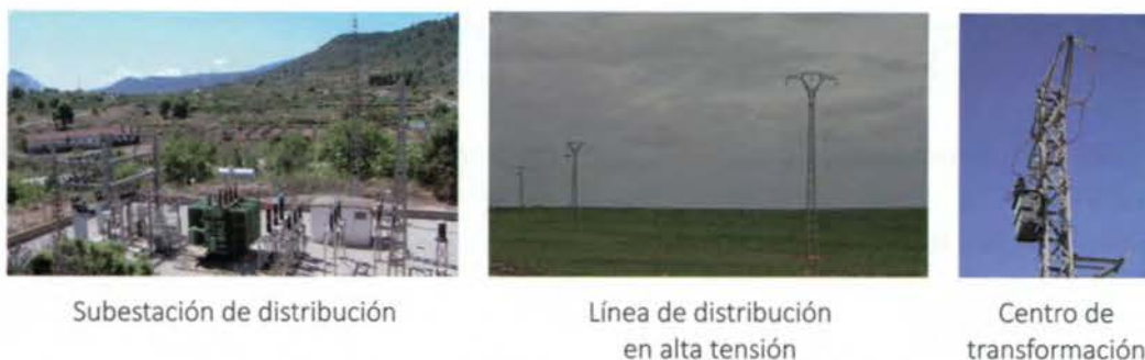
Figura 1.6. Algunos elementos del subsistema de distribución.
