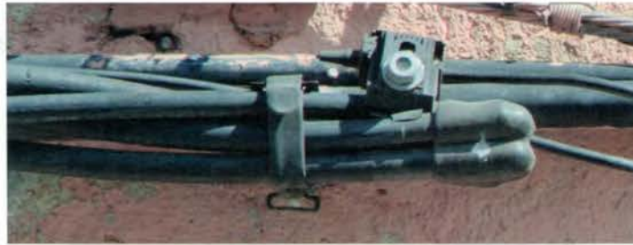
Figura 3.16. Detalle de un capuchón tetrapolar colocado al final de una red posada.
