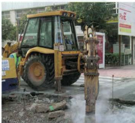
Figura 4.15. Medios mecánicos para romper la calzada.
