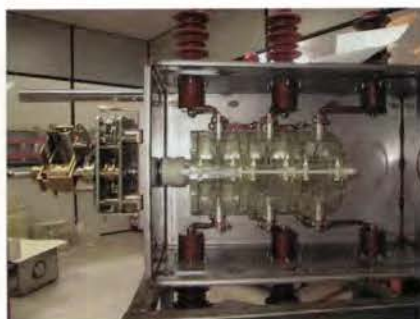
Figura 2.33. Interruptor-seccionador de corte en SF 6 .
