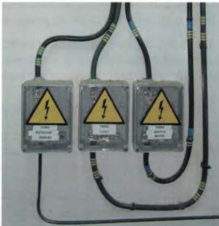
Figura 2.43. Puntos de registro de las puestas a tierra.
