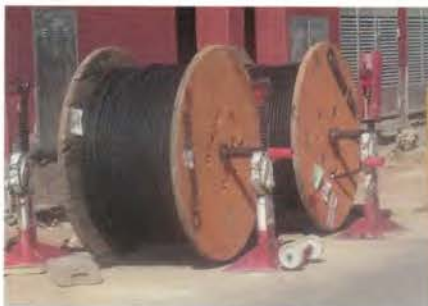
Figura 3.23. Bobinas apoyadas en caballetes para facilitar el tendido del cable.
