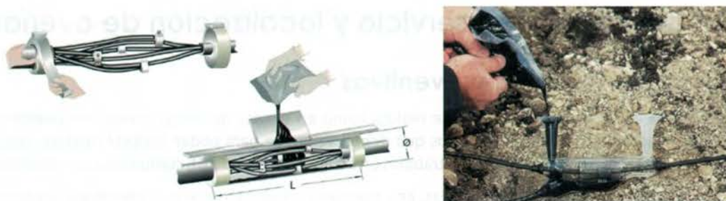
Figura 4.36. Ejecución de empalmes mediante kits de resinas. (Fuente: SAGA y 3M).
