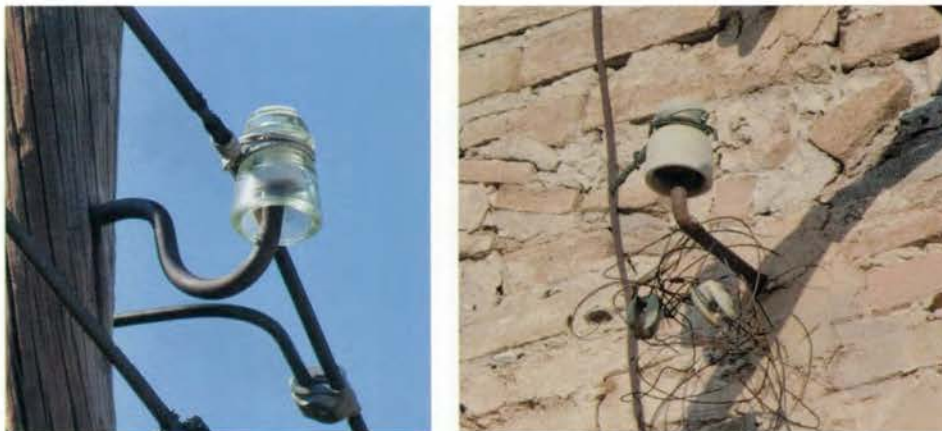
Figura 3.29. Aisladores para líneas aéreas de BT con conductores desnudos: en la parte izquierda de vidrio y de material cerámico a la derecha.
