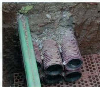
Figura 4.12. Tubos de polietileno para cables de telecomunicaciones.
