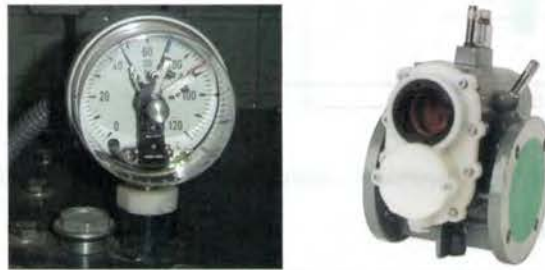
Figura 2.21. Protección de sobrecargas con termómetro/relé Buchholz.
