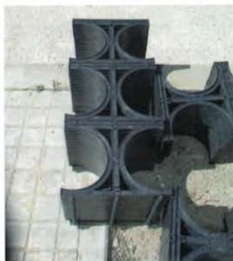
Figura 4.18. Separadores de tubo para posicionado exacto.
