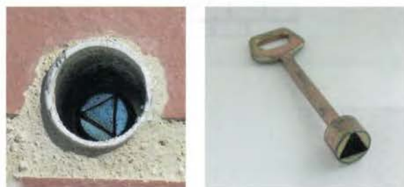
Figura 6.11. Detalles del cierre del nicho de la CGP. A la izquierda un ejemplo de cerradura triangular empleada por algunas compañías eléctricas y a la derecha la correspondiente llave.
