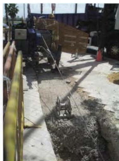
Figura 4.23. Proceso de tendido con ayuda de cabestrante.
