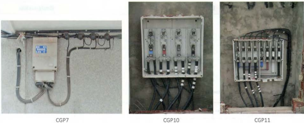
Figura 6.13. Fotografías de CGP de diferentes esquemas.
