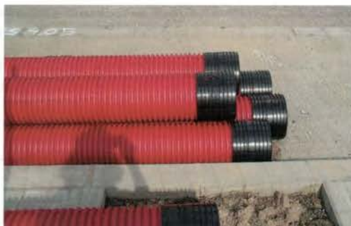
Figura 4.9. Tubos de polietileno para redes enterradas de BT.
