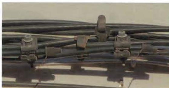
Figura 3.12. Detalle de la ejecución de una derivación en una red posada. Se observa que el final del cable derivado se protege de la humedad y otros agentes atmosféricos mediante un capuchón aislante que incorpora el conector de perforación de aislamiento.
