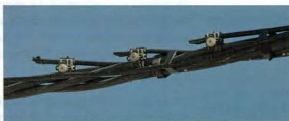
Figura 3.33. Derivación en una red aérea tensada.
